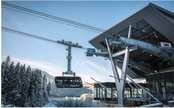
© Bayerische Zugspitzbahn Bergbahn AG
