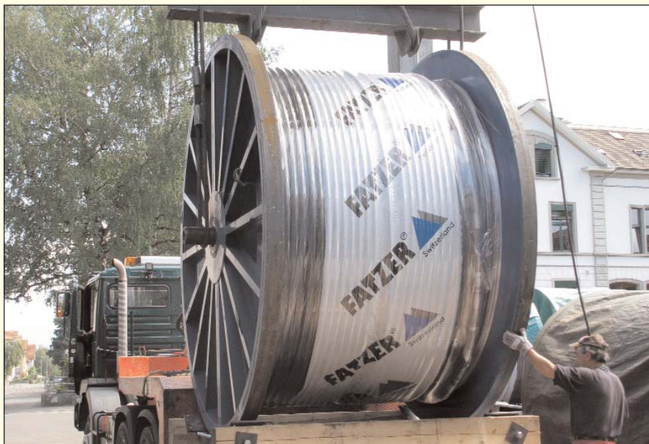
Seiltransport für die neue Pendelbahn von Murtél auf den Corvatsch. Zwei der vier 56 mm Tragseile sind INTEGRA DATA Seile mit integrierten Lichtwellenleitern Fotos: FATZER
