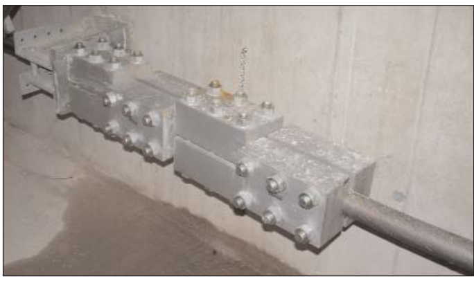
Superlativen auch beim FATZER-Seilen (im Bild das 70-mm-Tragseil): Seilgewichte: Zugseil 27,6 t (3.200 m lang- Durchmesser 47 mm) - Gegenseil 10,2 t (3200 m lang) - Tragseile 97,4 t (3430 m lang) = insgesamt also 140 t Eigengewicht der Seile!
